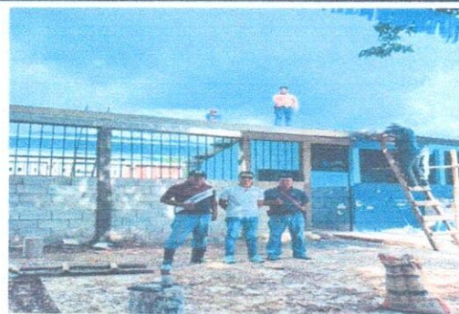
Foto 2: Se observa la instalación de costaneras del módulo.
