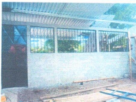
Foto 5: Se observa la instalación de láminas troqueladas del techo del módulo.
