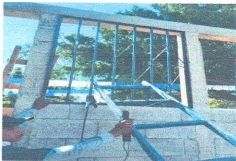
Foto 3: Se observa la instalación de ventanas del módulo.
